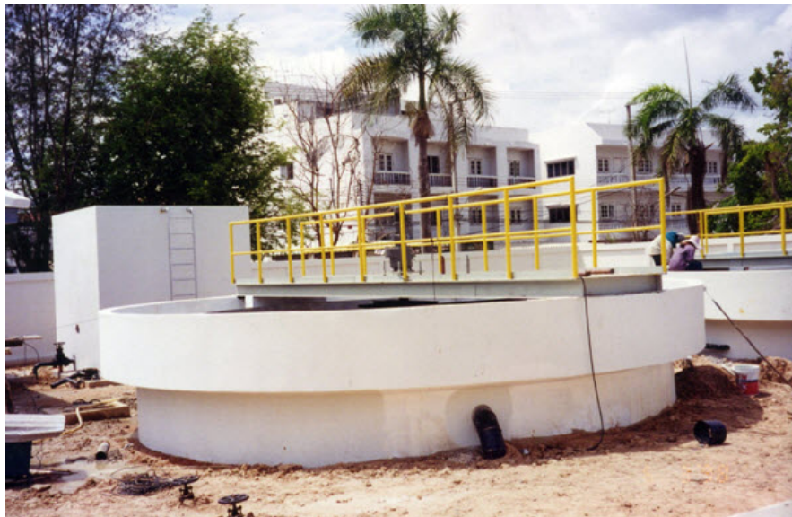
ถังตกตะกอนแบบสะพานวางพาดเต็มบ่อพร้อมชุดขับเคลื่อนวางกลางถัง (Center Drive Full Bridge Clarification)
