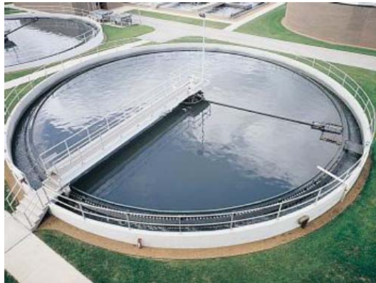
ถังตกตะกอนชนิดสะพานครึ่งบ่อแบบขับเคลื่อนจากกลางบ่อ
